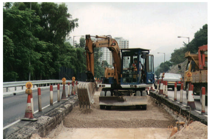
重鋪道路 Road reconstruction
