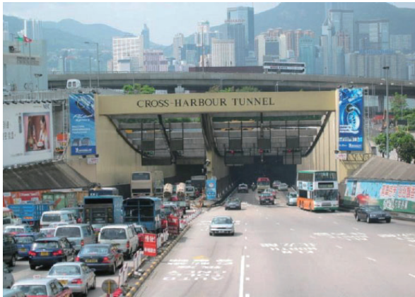
海底隧道 Cross-Harbour Tunnel
