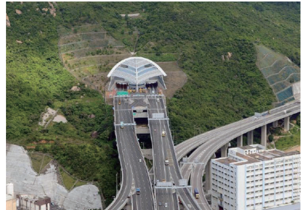
南灣隧道 Nam Wan Tunnel
