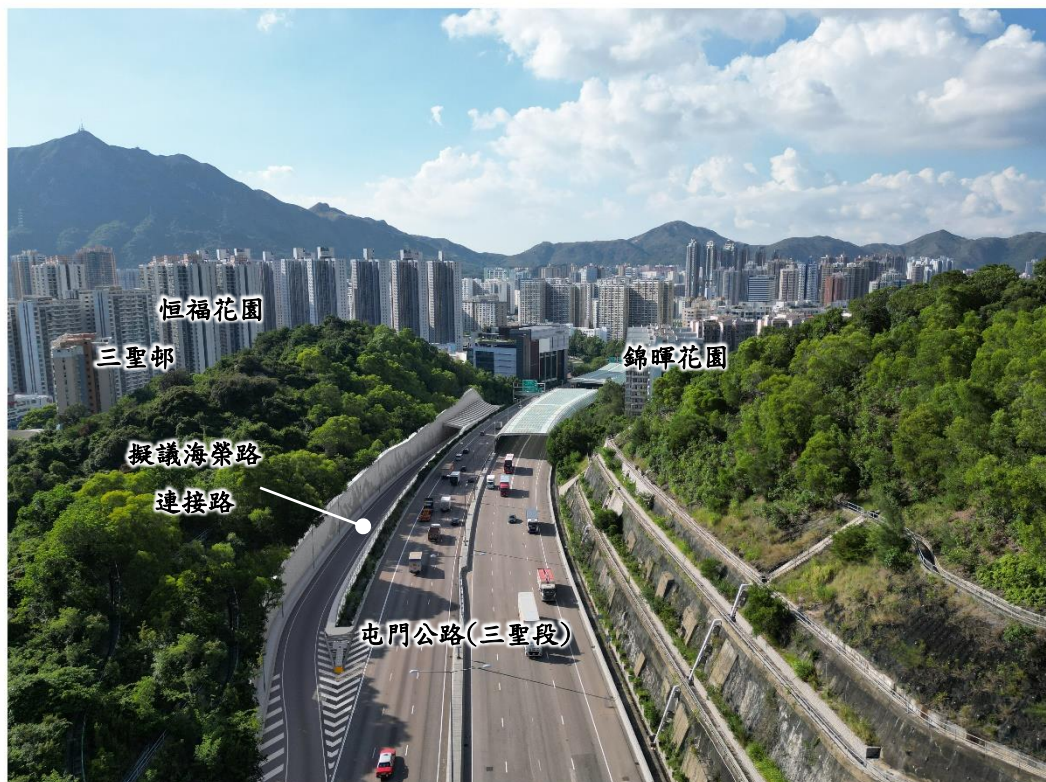
擬議的海棠路連接路擴建工程 (以上只供參考 - 最終佈局以詳細設計為準)
